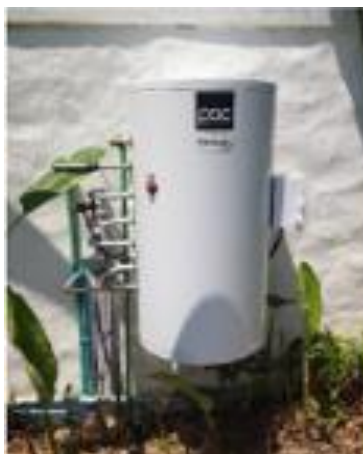
ใช้ระบบน้ำร้อนที่แลกเปลี่ยนความร้อนจากเครื่องปรับอากาศ (Heat Recovery Water Heater)
