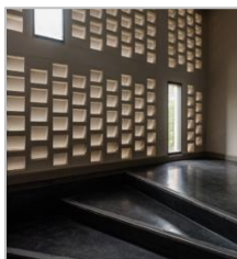
ติดตั้งระเบียง/ช่องแสง (Facade) ช่วยลดความร้อนเข้าสู่อาคาร และควบคุมแสงสว่างจากภายนอก
