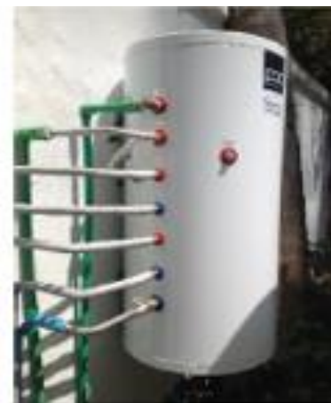
ใช้ระบบน้ำร้อนที่แลกเปลี่ยนความร้อนจากเครื่องปรับอากาศ (Heat Recovery Water Heater)
