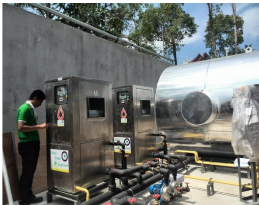
ติดตั้ง Heat Pump เพื่อผลิตน้ำร้อน แทนหม้อต้มที่ใช้ไฟฟ้า
