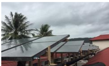
ติดตั้งเครื่องผลิตน้ำร้อนพลังงานแสงอาทิตย์ (Solar Collector) ทดแทนการใช้หม้อต้มน้ำร้อน
