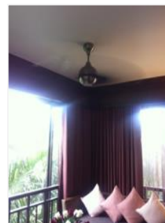
ติดตั้งพัดลมเพดานในห้องพัก เพื่อลดภาระการทำงานของ เครื่องปรับอากาศ
