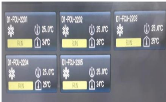
ระบบควบคุมการทำงานของเครื่องปรับอากาศเป็นระบบ VRF ซึ่งสามารถควบคุม สังเกตการณ์ และปิดระบบได้จากส่วนกลาง
