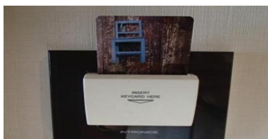
ติดตั้งอุปกรณ์ควบคุมการใช้ไฟฟ้า ในห้องพักเมื่อไม่มีผู้พักในห้อง
