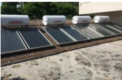
ติดตั้งเครื่องผลิตน้ำร้อนพลังงานแสงอาทิตย์ (Solar Collector) ทดแทนการใช้หม้อต้มน้ำร้อน
